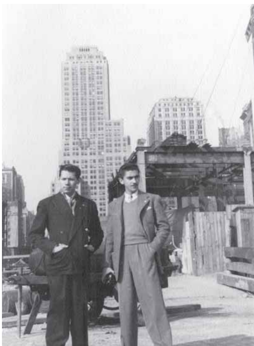
Enrique Lavalle Arredondo y Gerardo González visitan una obra en Nueva York, centro del auge de enormes construcciones muy planificadas y cuya edificación suponía muchos años de trabajo.
