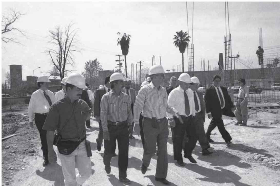
La primera etapa de construcción comprendió las obras de excavación. Para ese momento el Gobierno Federal tenía aportados 15 millones pesos. En ambas páginas, visita a las obras.
