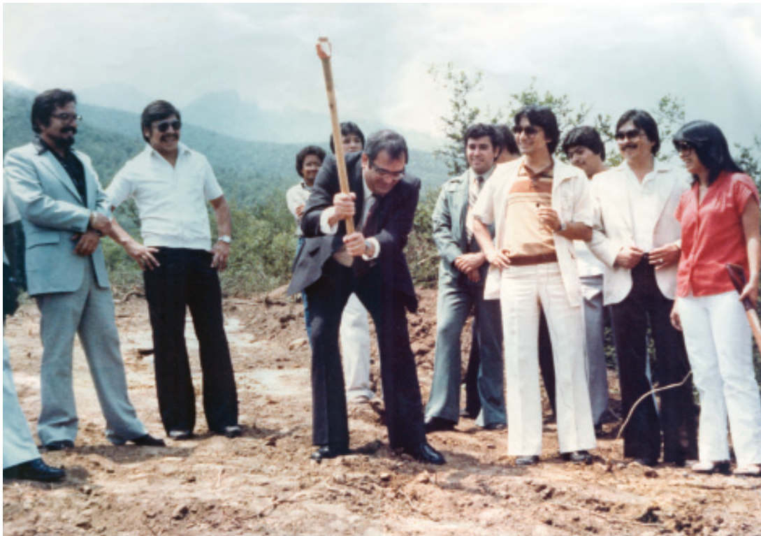
El Rector Dr. Alfredo Piñeyro López inicia la construcción de la Facultad de Ciencias de la Comunicación en la Unidad Mederos, al sur de Monterrey, el 29 de agosto de 1980. El Lic. Ernesto Rocha atestigua el simbólico evento.
