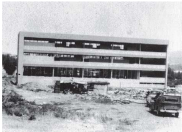
Construcción de la nueva sede en la Unidad Mederos. Arriba, el arquitecto Armando V. Flores Salazar toma protesta como primer director.
