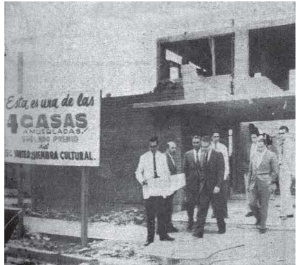
El gobernador Raúl Rangel Frías visita en los primeros días de octubre de 1959 las obras de una de las residencias en construcción que serían entregadas en el sorteo número 15. Lo acompañan, entre otros, el rector Joaquín A. Mora y Humberto Solano Reyes.
