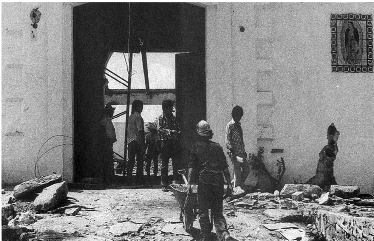
La ex hacienda de Guadalupe, que presentaba un evidente deterioro a causa del paso del tiempo, requirió una remodelación total para acondicionar oficinas administrativas y laboratorios para el trabajo de investigación de los institutos.
